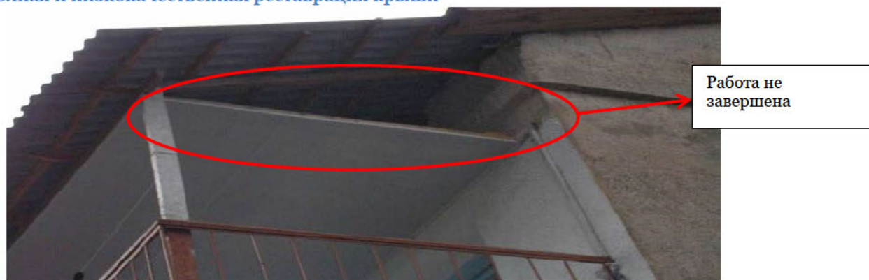
Рис. 30 - Низкокачественная реставрация крыши
