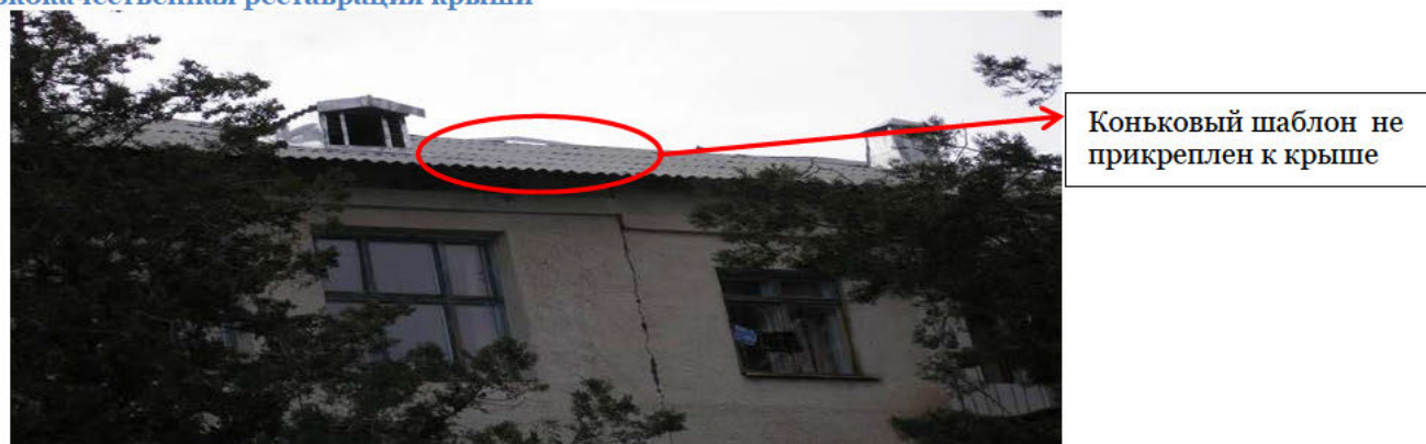
Рис. 30 - Низкокачественная реставрация крыши
